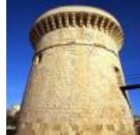
Torre de la Illeta [4]
